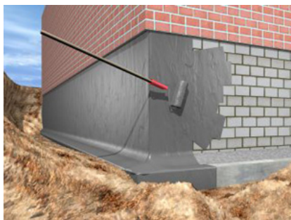
Гидроизоляция фундаментов и плит пола
